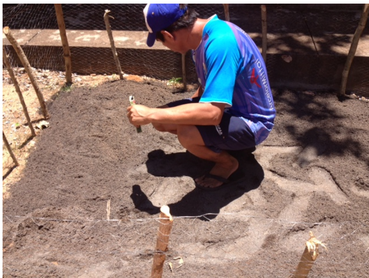
Roger, aanleg tuin.
